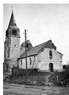
L'église en 1918, avant sa reconstruction.
